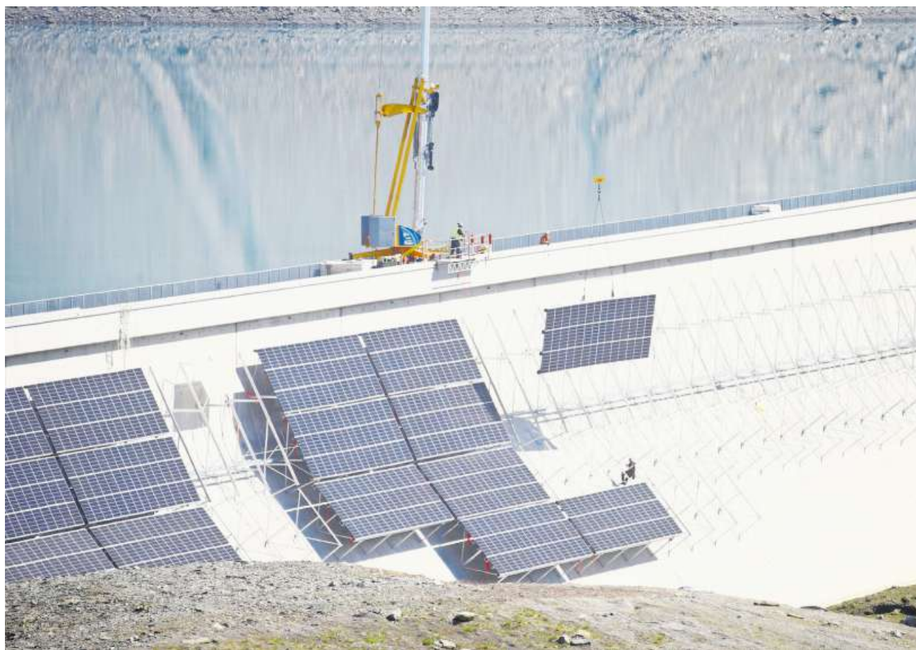
Installation von Solarpaneelen an der Staumauer des Muttsees im Kanton Glarus auf 2500 Metern über Meer. ARND WIEGMANN/REUTERS
